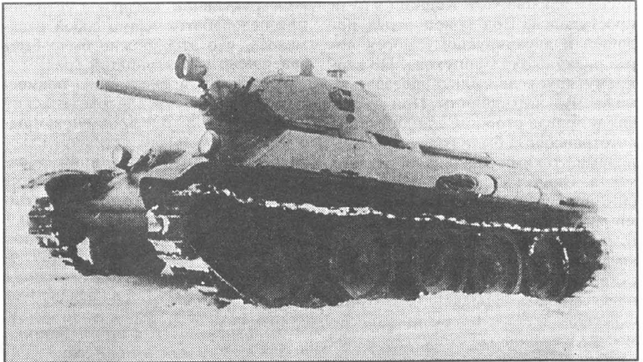
Один из двух прототипов Т-34 на испытаниях зимой 39-40 гг.
