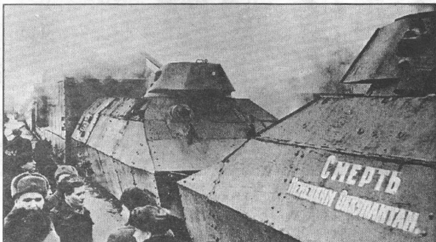
Также широко башни Т-34 использовались и на бронепоездах, но в данном случае для изготовления броневозов использованы не только башни но и корпуса "тридцатьчетверок" образца 1941 г.!
